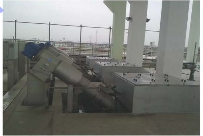
RPPS/1600细格栅应用于无锡太湖治理MBR工艺污水项目
