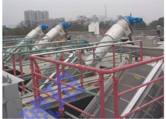
Ro2/2000转鼓细格栅工程安装中
