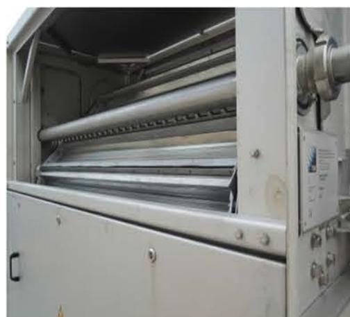
压力冲洗水棒全覆盖喷射冲洗
