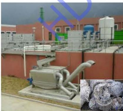
与超细膜格栅配套的渣水压榨机
