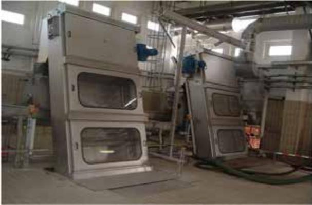
FSM耙齿回转格栅室内全封闭安装
