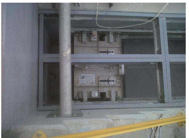
曝气沉砂池浮渣/油脂刮板
