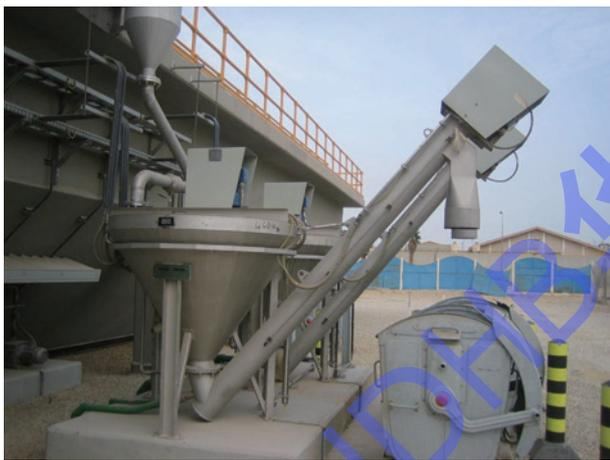
洗砂装置应用于曝气沉砂池洗砂分砂处理
